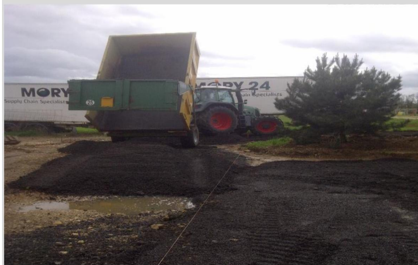
Mise en œuvre matériaux recyclés type fraisât
